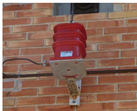
Montaje y anclaje
